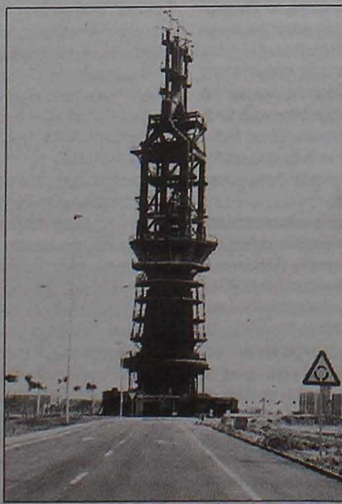
El deterioro del Horno Alto nº2 es patente (Higuera)
