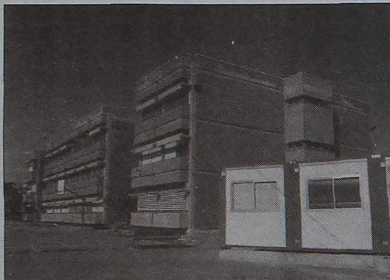
Vista del Instituto Clot del Moro y de las aulas prefabricadas
