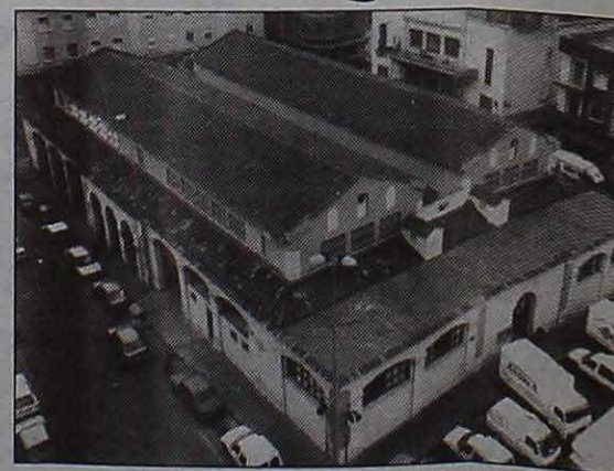
Mercado municipal de Puerto de Sagunto que se está rehabilitando (foto Higuera)
