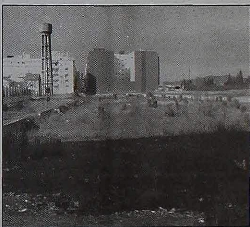
Parcel·la on es realitzaran les obres al carrer Unificació (Higueras)
