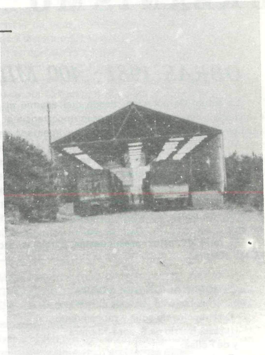
1 - Vista exterior de la estación de camiones.
